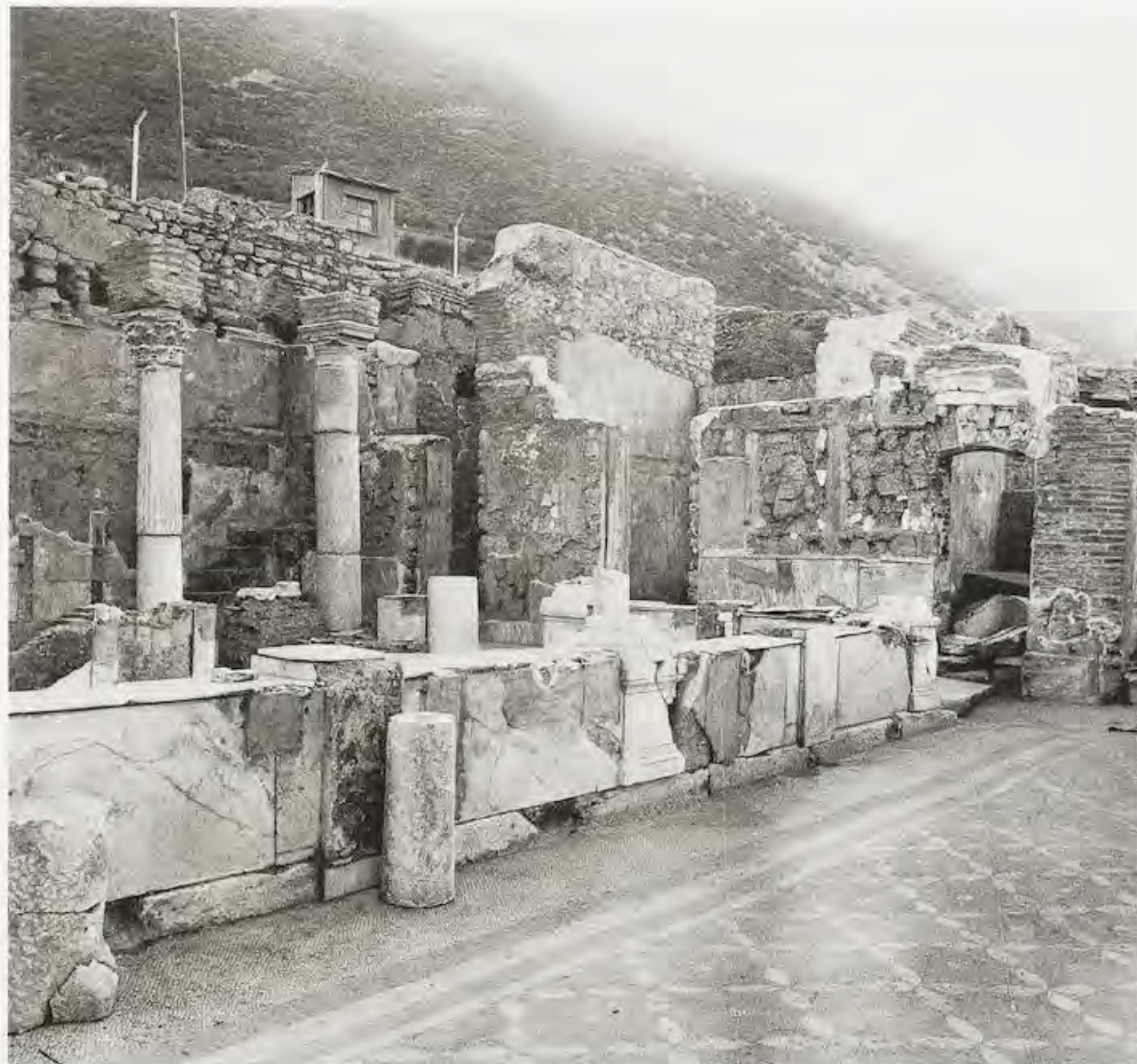
164: H 2, WOHNUNG II, WESTLICHE ZIMMERFLUCHT
