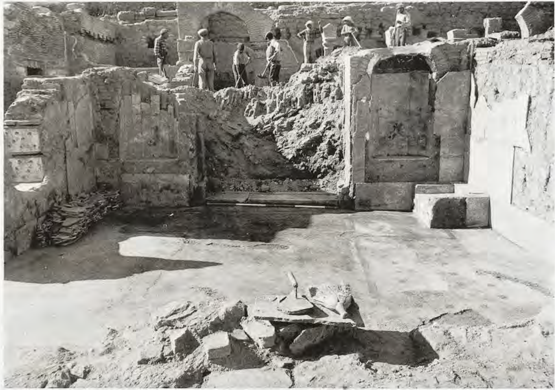
158: H 2/SR 24, BRUNNENNISCHEN IN DER SÜDWAND
